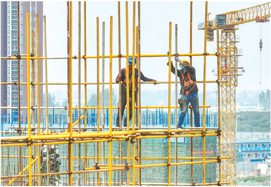
我市常态化疫情防控工作有序推进。施工单位在严格落实疫情防控措施的前提下,抓进度、抢工期,保障项目建设顺利进行。图为5月8日牡丹江路一建设项目施工现场。本报记者 焦海洋 摄
