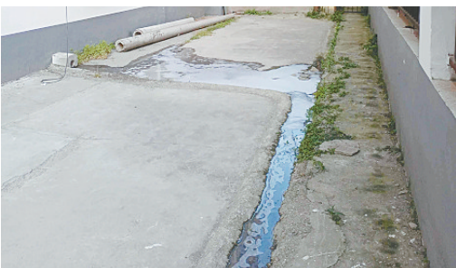
环城路与岷山路交叉口，三元住宅小区2号楼南侧，污水乱排。
