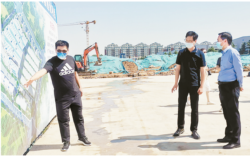
市司法局法治保障员到项目工地开展法治体检服务。 许 乐 摄
