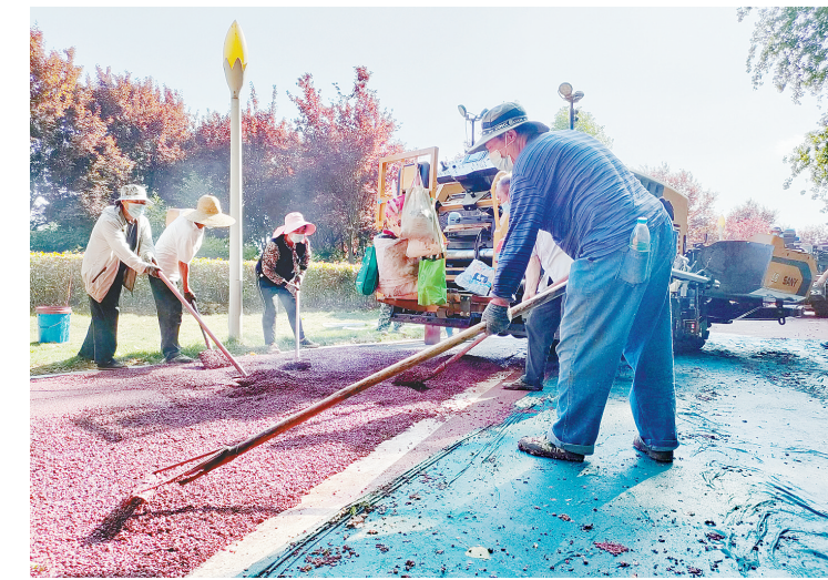
工人正在铺设彩色沥青。
