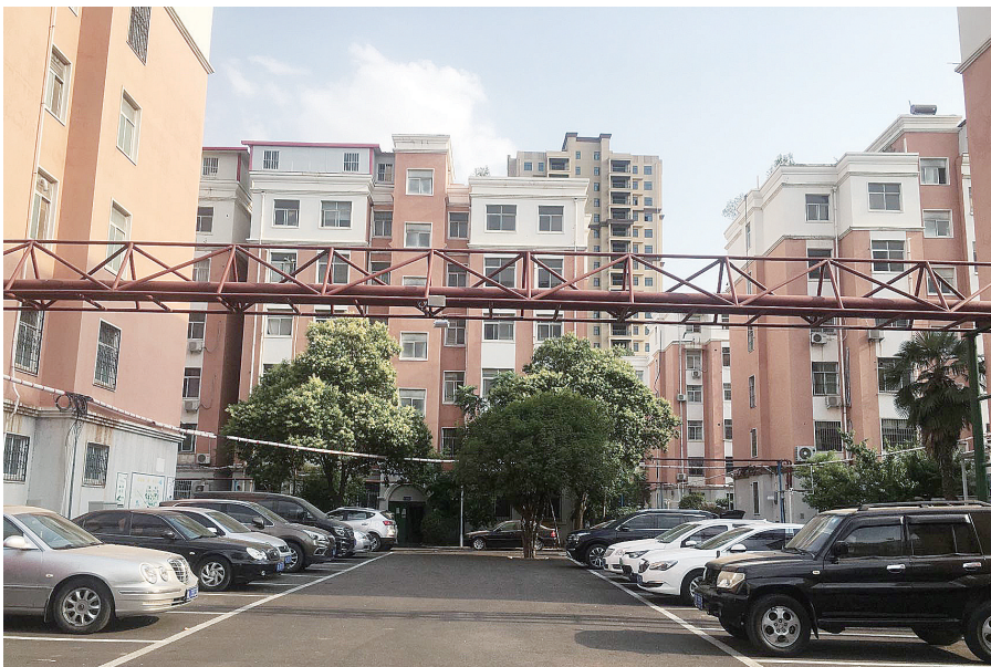
沙田世纪苑小区,空中管线规整有序,停车位设置合理,路面平坦干净。
