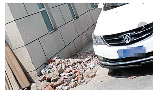
五一路与受降路交叉口向北约50米路西,建筑垃圾无人清理。
