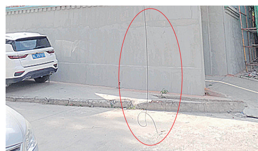
文景五巷与文景路交叉口向南约60米路西,线缆低垂。
