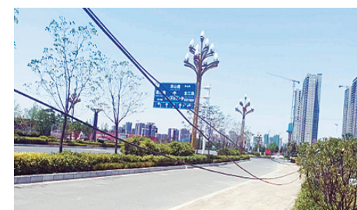
牡丹江路与解放路交叉口附近,线缆垂落。
