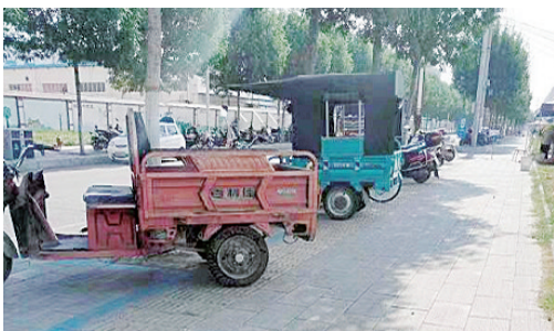
珠江路与香山路交叉口向东约140米路南，非机动车占压盲道。
