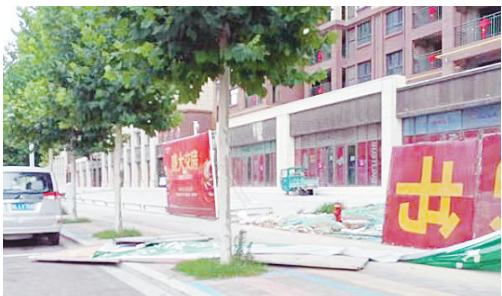
青龍山路与庐山路交叉路口向西约30米路北,施工围挡倒地。
