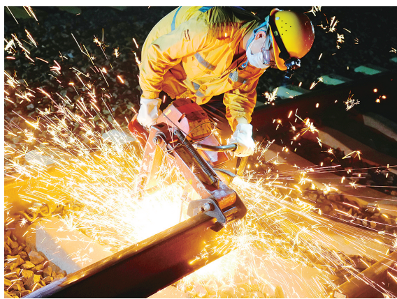
7月12日,中国铁路上海局集团有限公司检修人员在大胜关长江大桥上对高铁线路铁轨进行维修。 新华社记者 李雨泽 摄
