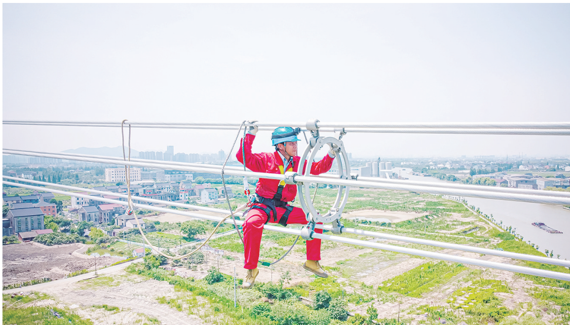
7月12日,国网浙江电力的电力工人对新建设成的白鹤滩—浙江特高压直流输电工程线路进行竣工验收工作。 新华社记者 江汉 摄
