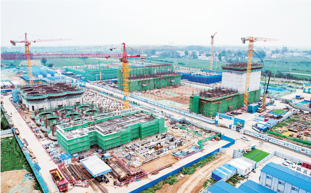
7月16日,经济技术开发区中粮粮谷90万吨小麦深加工项目施工现场,建设者在紧张施工。该项目总投资20亿元,占地面积200亩。项目建成后,年加工小麦90万吨,可实现年产值21亿元,将大幅提高全市粮食深加工水平、拉长粮食产业链条,为食品企业提供有力的原材料支撑。
