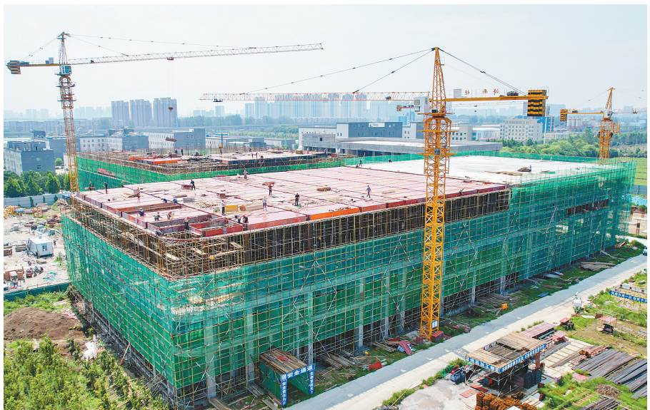
7月18日，位于淞江产业集聚区的微康微生态研究院项目工地正在紧张施工。 本报记者 焦海洋 摄
