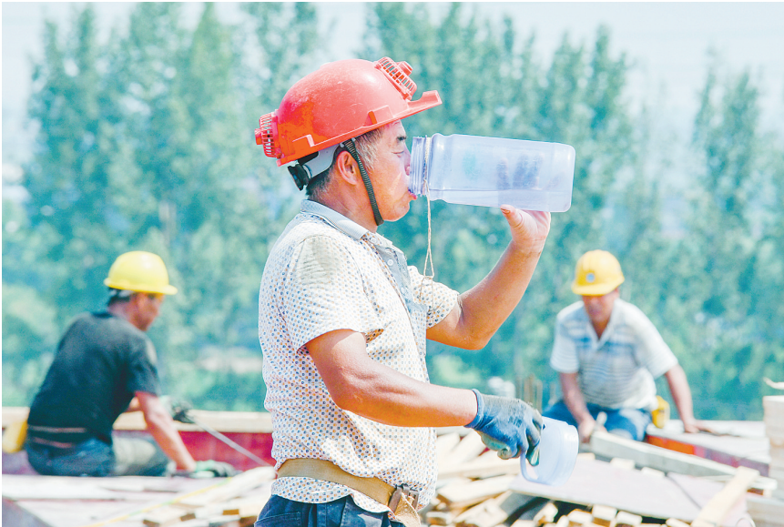
7月18日,在我市一重点项目施工工地,工人不畏高温坚守岗位。 本报记者 焦海洋 摄
