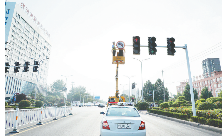
工作人员在安装“禁止左转”交通标识牌。 本报记者 范子恒 摄
