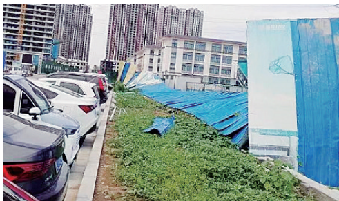
牡丹江路与解放北路交叉口向西约90米路北,围挡倒地。
