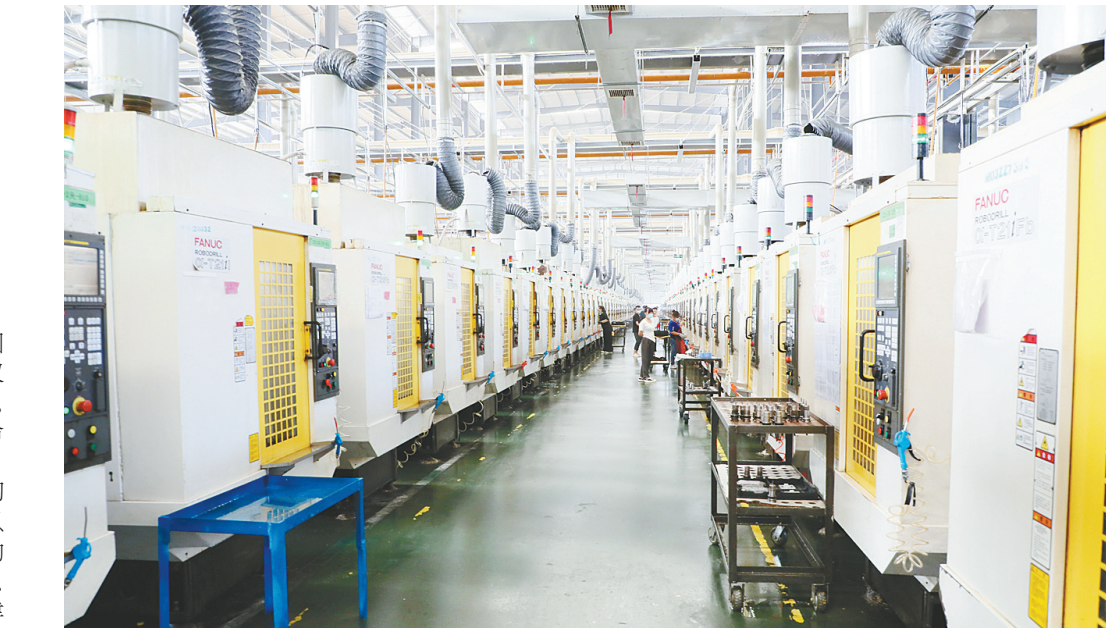
8月9日，建泰精密科技产业园CNC生产线满负荷生产中。临颍建泰精密科技产业园占地230亩，建成7栋标准化厂房及配套用房，安装国际先进CNC生产线16条、设备6000余台套，年产苹果、华为等知名手机配件1.4亿套。
