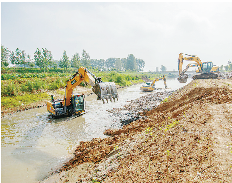
马拉河治理施工现场。
