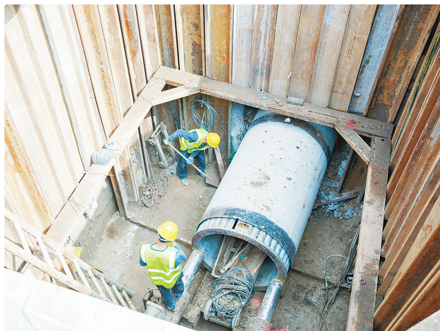
图为雨污分流施工现场（资料照片）。
