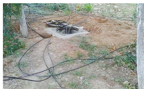
金山路与滨河东路交叉口向南约160米路东，绿化带内井盖移位。
