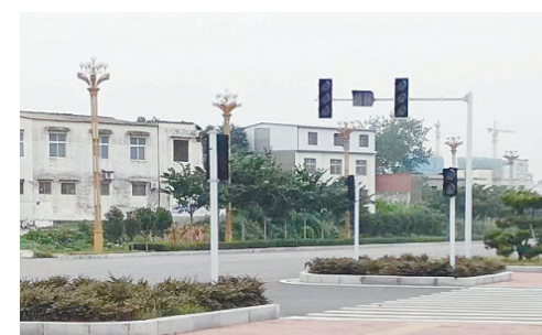
湘江东路与东山路交叉口向西约400米处，交通信号灯不亮。
