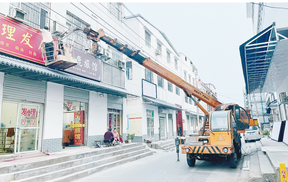
8月24日,施工工人正在安装仿古雨搭。连日来,源汇新区丁湾村对街道两侧、背街小巷的广告牌进行了规范化改造。 本报记者 王嘉明 摄
