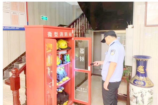
检查单位消防安全设施
