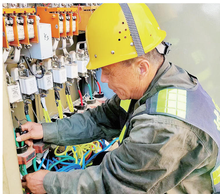
工作人员在燕山路对路灯控制柜线路进行维修。
