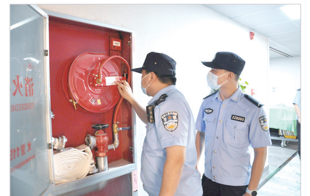
检查消防设施。
