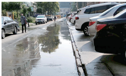
太行山北路与岷江路交叉口向北约150米路西,下水道堵塞,污水外溢。
