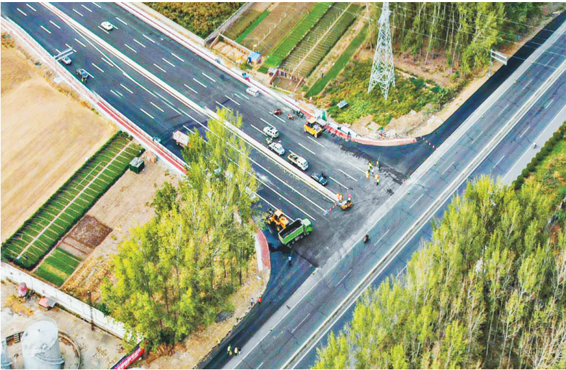
107国道至西环路连接线工程已经进入收尾阶段。
