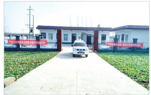
南水北调分水口管理房
