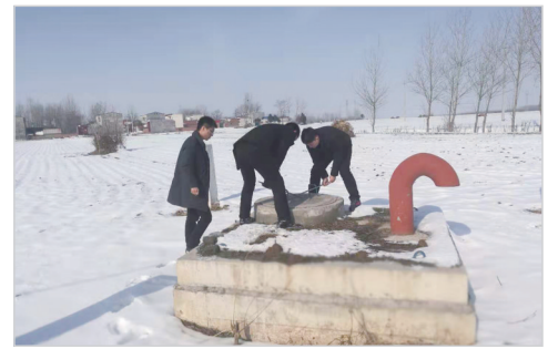
南水北调管线日常巡查维护
