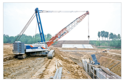
南水北调建设期输水管吊装
