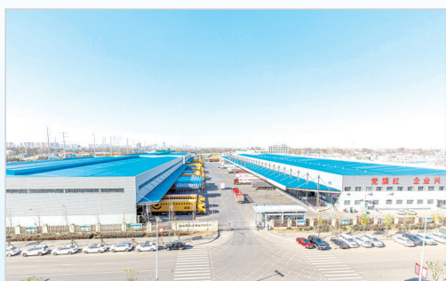
临港科创园伊利集团豫中南分拨中心。
