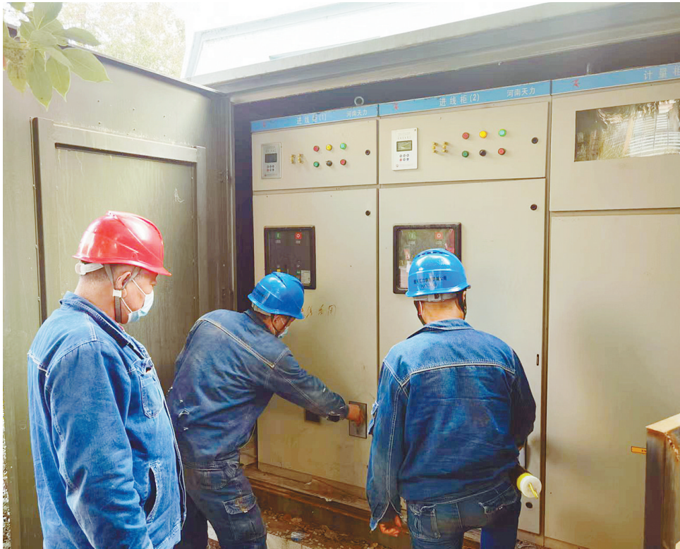
国网漯河供电公司西城供电部工作人员在碧湖御苑小区排除故障。
