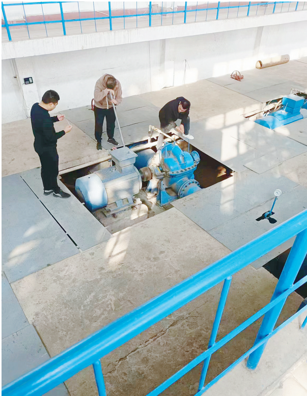
市清源供水有限公司第四水厂工作人员正在抢修设备。
