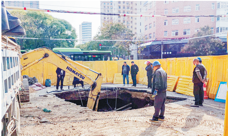
工作人员正在塌陷处维修。 本报记者 杨光 摄
