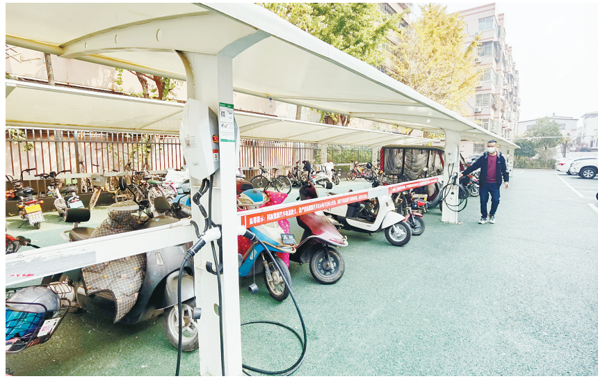
建安小区新建的充电棚。
