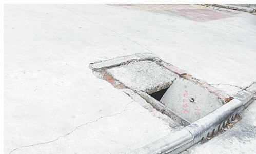
祁山路与会展路交叉口向南约30米路西,井盖破损。
