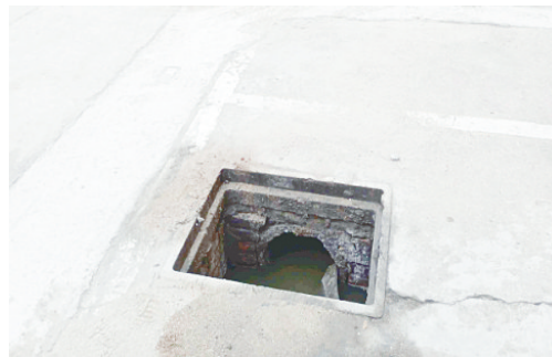
盛隆碧水湾小区2号楼3单元东侧，井盖缺失，存在安全隐患。
