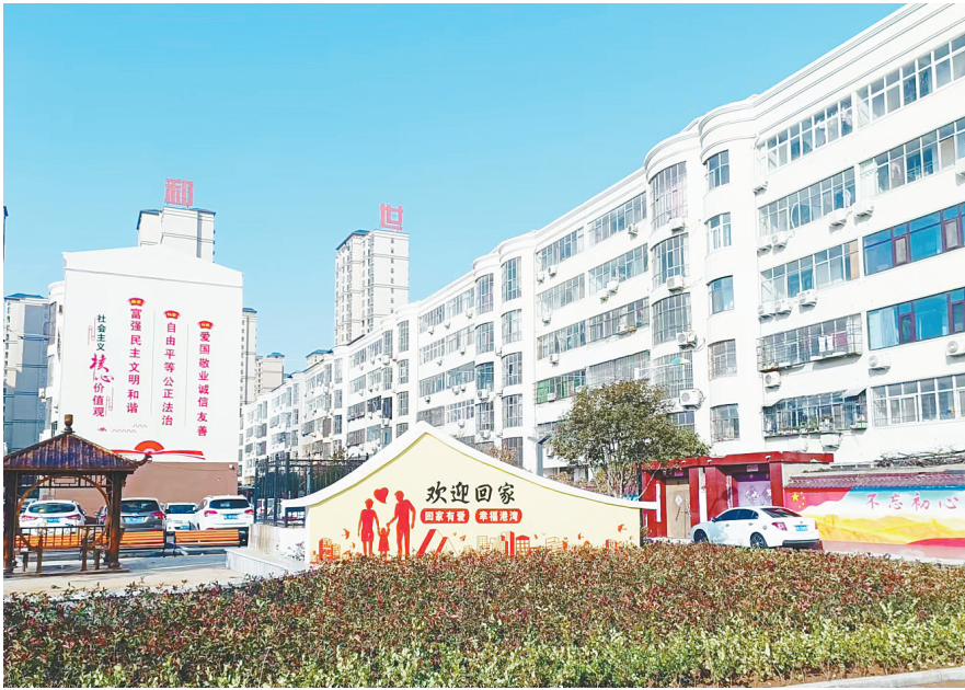
改造后的阳光花园小区。
