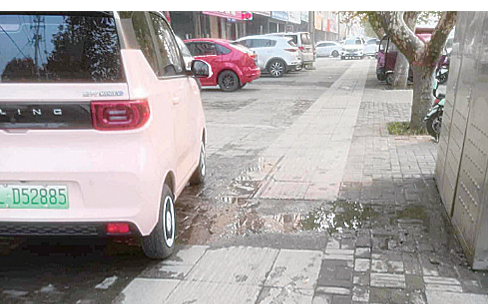
太行山北路与龙江西路交叉口向南约30米路东,商户向人行道排放污水。
