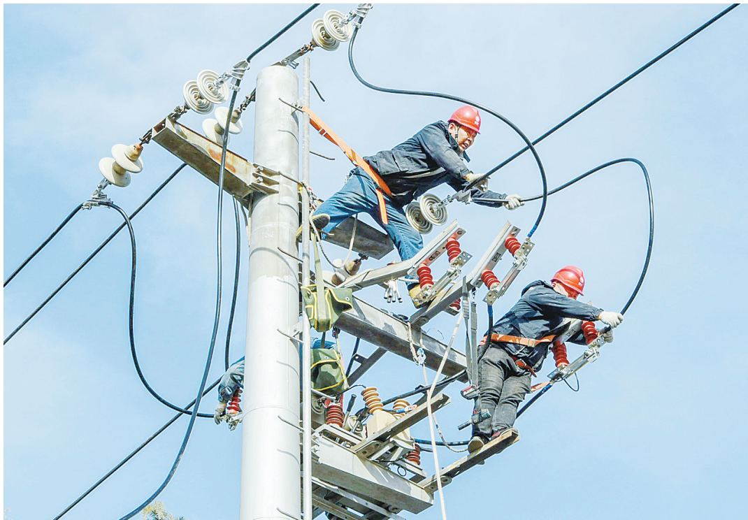
国网漯河供电公司工作人员正在架设线路。
