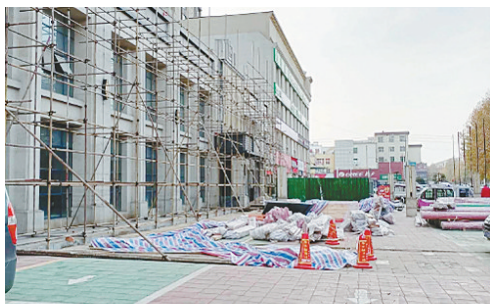
湘江西路与五一路交叉口向东约50米路南，临街门店装修无围挡。
