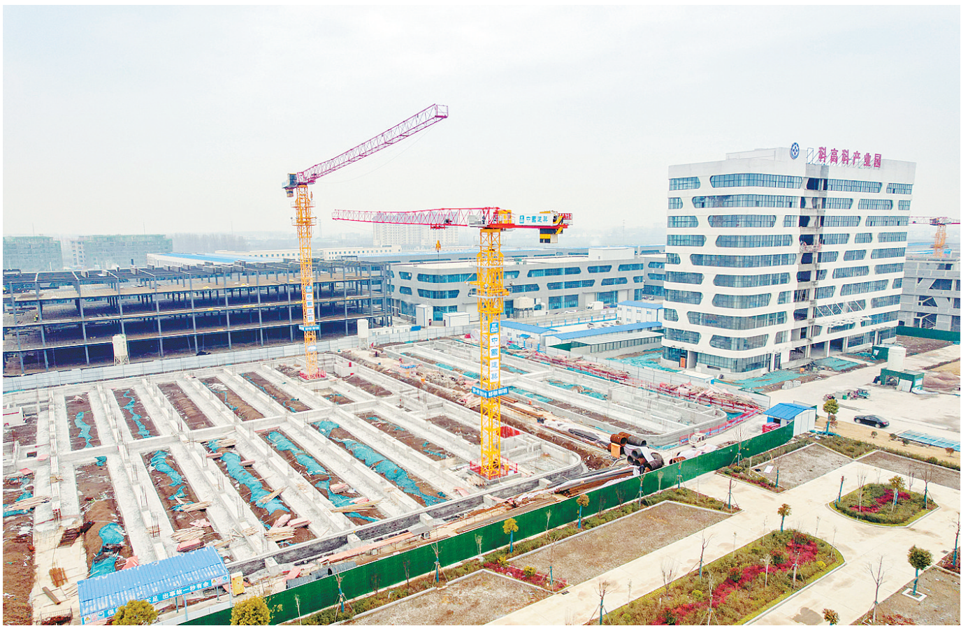
2月16日，记者在位于郾城先进制造业开发区的中科高科产业园项目工地看到，该项目科研大楼正在进行外墙装修，生产车间主体框架基本建成，配套工程有序推进。该项目建成后将为我市产业转型升级和绿色发展提供新动力。 本报记者 焦海洋 摄
