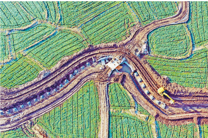
2月16日，在浙江省台州市仙居县双庙乡，工人在水渠及机耕道路施工现场施工（无人机照片）。
