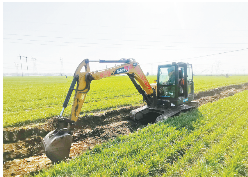
2月19日,在召陵区召陵镇,挖掘机正在清理排水沟内的杂物。连日来,该镇组织人力物力清理沟渠内的杂物,打通排水“脉络”,增强沟渠蓄水和防内涝能力。 本报记者 范子恒 摄
