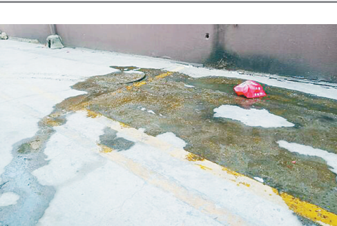
湘江西路市环卫处东50米路南416号院口，污水外溢。
