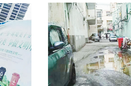
辽河路与舟山路交叉口向西约10米路北，排水管道堵塞，污水外溢。
