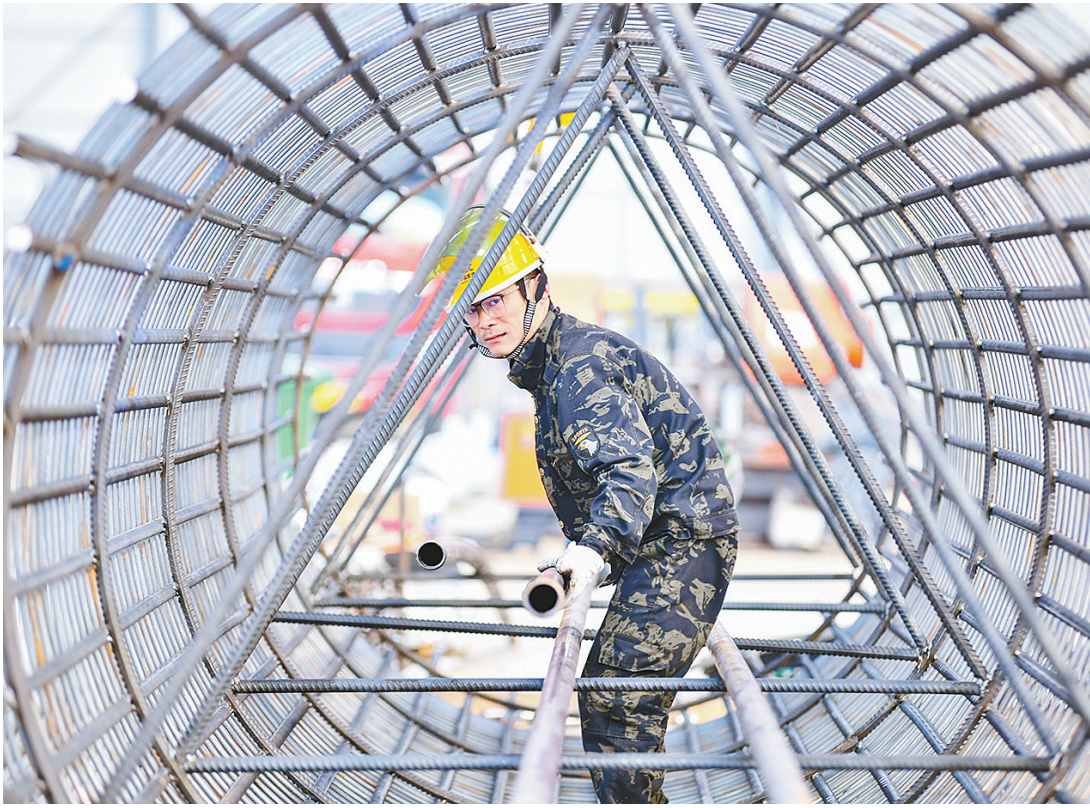
3月8日,位于市城乡一体化示范区的国道107京港线项目全线控制性工程沙河特大桥钢筋加工场内,工人正在制作桩基钢筋笼。据悉,国道107京港线漯河境新建工程项目北接许昌、南连驻马店,穿越我市1县3区11个乡镇,建设里程67.5公里,总投资约56亿元,全段采用一级公路标准,是我市建省辖市以来投资最大、建设里程最长的交通项目。
