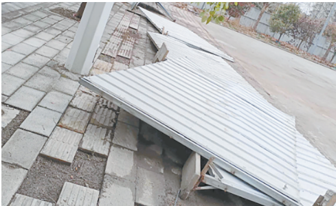
王屋山路与柳江路交叉向北约100米路西，围挡倒地。
