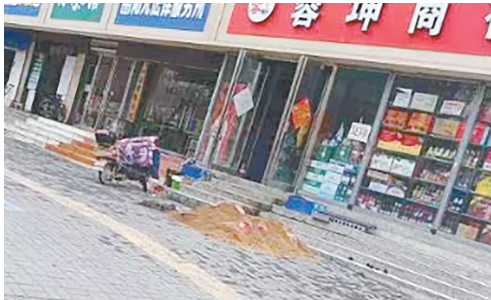
海河路与东山路交叉口向东约2米路南，门面房前堆放沙土。
