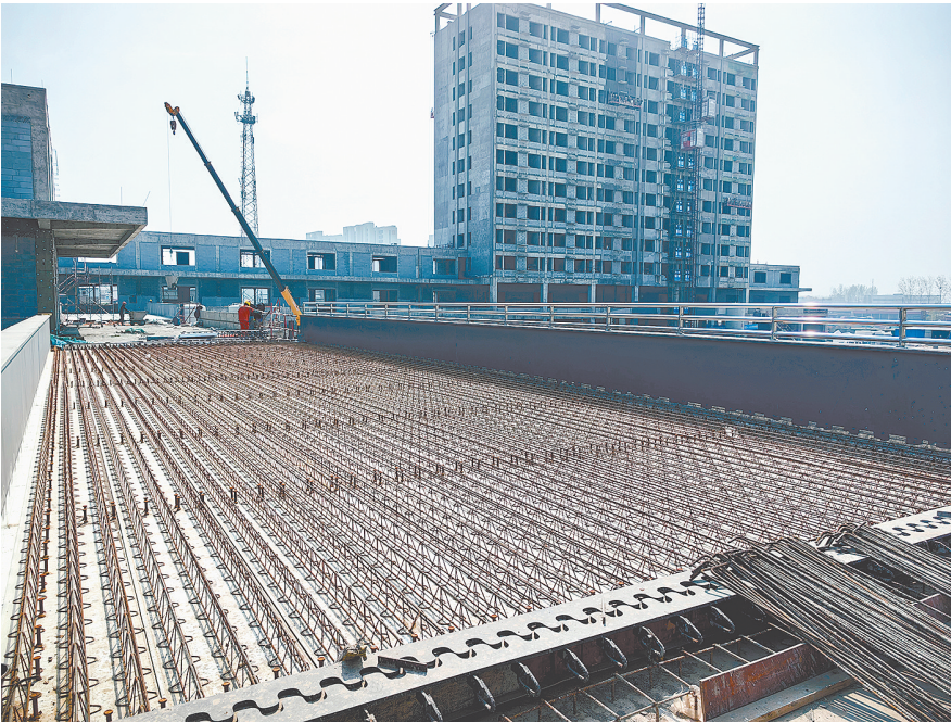
漯河万邦农产品批发市场冷链物流园项目一期汽车车道建设工地。
