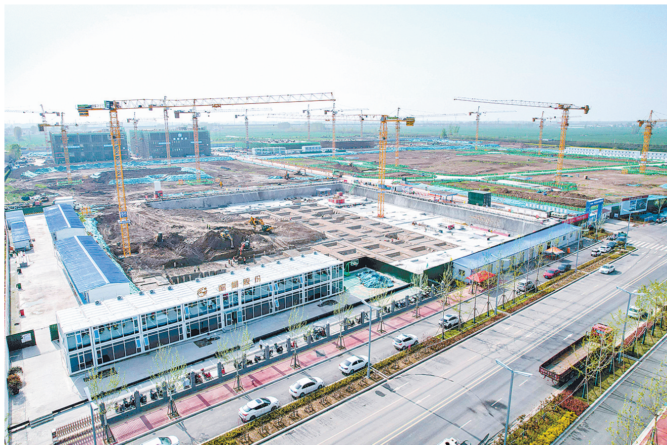
4月11日，河南食品科创园项目建设现场，工人正在抢抓工期赶进度。
