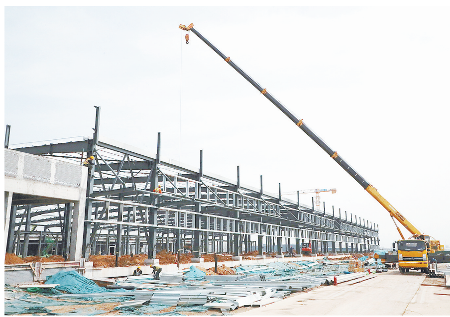
4月11日,双汇第三工业园正在紧张施工中。
