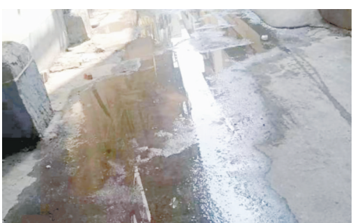
柳江路与嵩山路交叉口向西约180米路南，重庆麻辣小面临街楼后面，排水管道堵塞。
