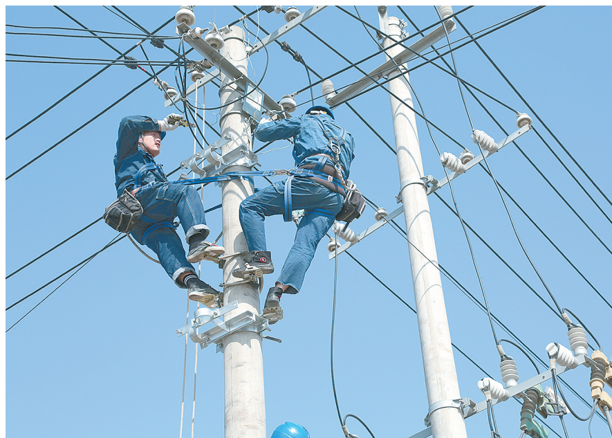
新店镇长河李村变压器改造施工现场。
