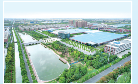
泰格生物医药产业园
