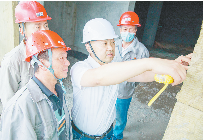
援疆干部寇占伟在伊吾县工地指导工人作业。
