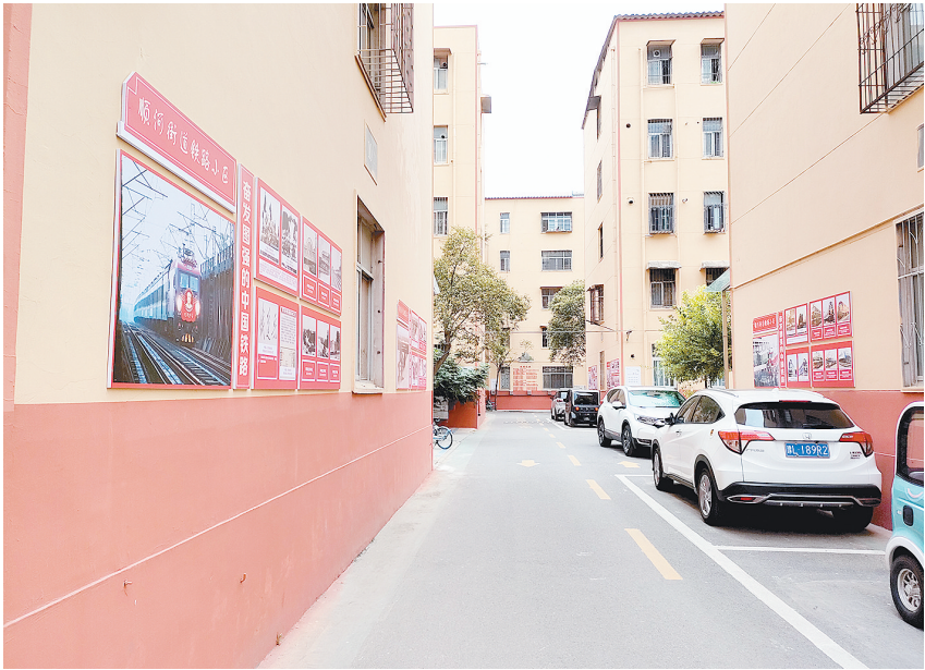
改造后的铁路小区焕然一新。
